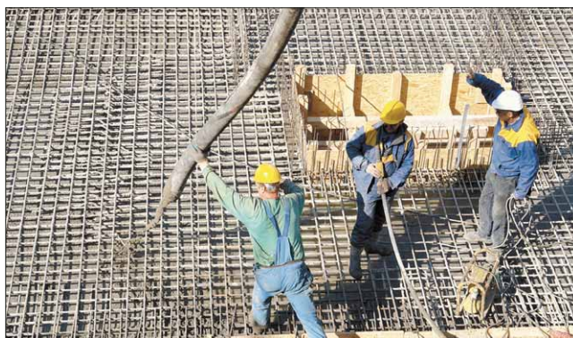
Piata cimentului a fost anul trecut la un nivel de aproape 600 mil. euro, jumătate față de maxim, dar producătorii au continuat să toarne profit
