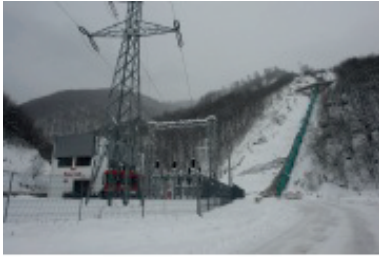
Hidrocentrala Raul Alb
