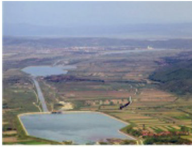
Amenajarea Raul Mare aval
