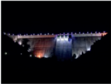
Baraj Izvorul Muntelui - Bicz
