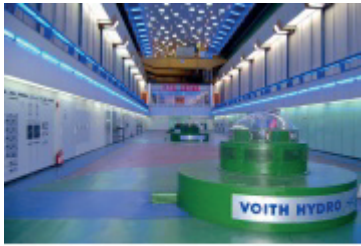
Hidrocentrala Lotru - Ciunget
