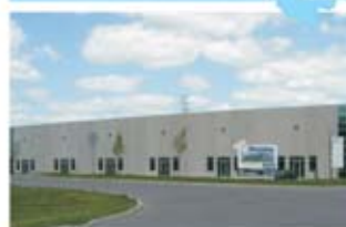
GARA CĂTELU INDUSTRIAL CENTER - ÎNCHIRIERE Spații depozitare clasă A, suprafețe închiriale de la 1.000 mp până la 20.000 mp. 0740 104 549
